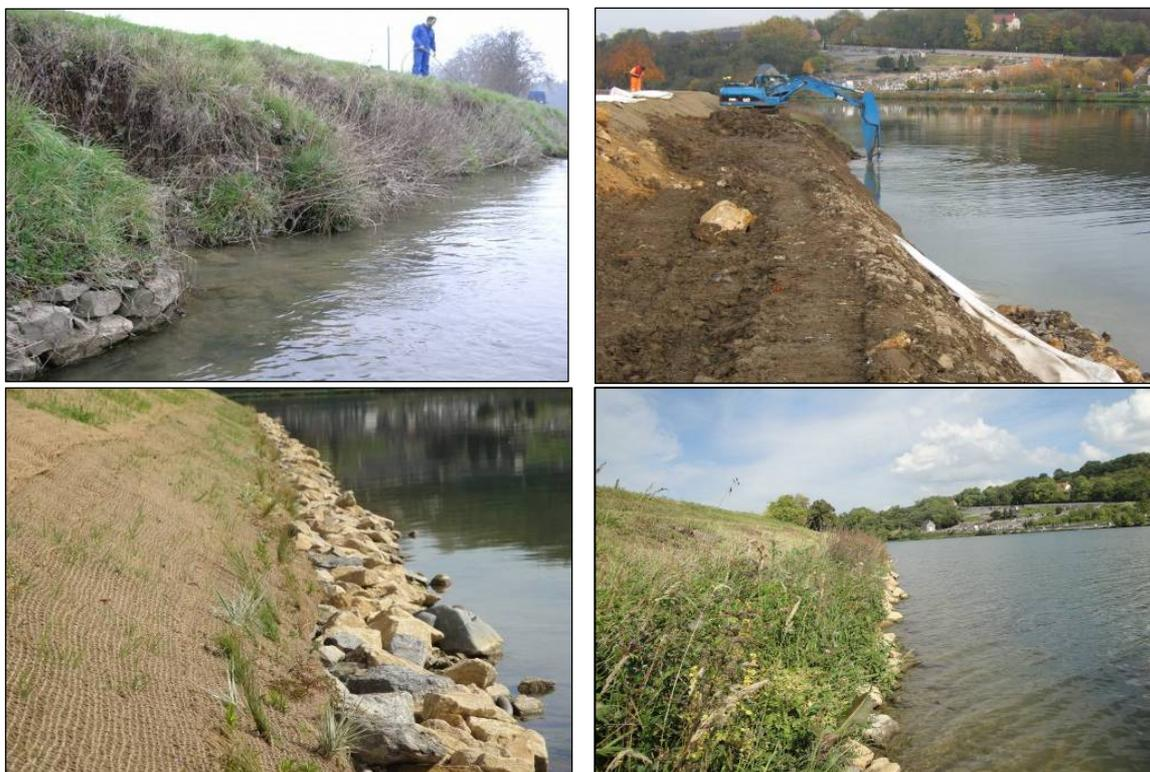
Figure 10. Vues successives d'un chantier de confortement de berge au moyen de techniques mixtes : empierrement de pied de berge et plantations de mottes d'hélophytes. La Meuse à Givet - Conception et suivi : F. PEGUIN (EGIS Eau).
