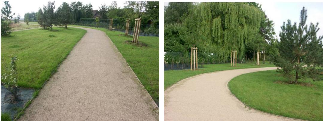
Figure 11. Exemple de cheminement piéton avec un revêtement en stabilisé renforcé.
