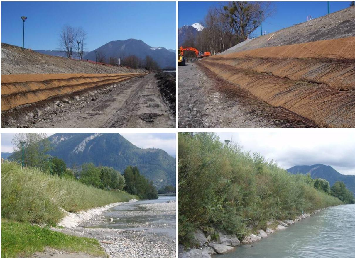
**Figure 5.** Exemple de chantier de stabilisation / restauration de berges au moyen de techniques mixtes : empierrement sous-fluvial surmonté de lits de plants et plançons renforcés par des boudins de géotextile biodégradable. L'Arve à Cluses (74) : état de l'ouvrage en fin de chantier (photos en haut - 24.03.05), six mois après l'achèvement des travaux (photo en bas à gauche – 14.09.05) puis deux ans et demi après l'achèvement des travaux (photo en bas à droite – 21.08.07).
