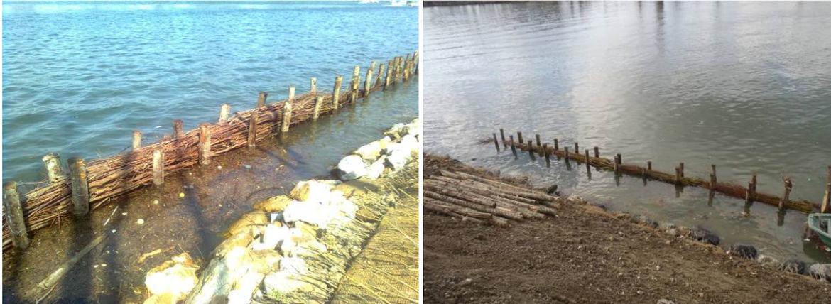
**Figure 7.** Vues du chantier de stabilisation/restauration de la berge gauche de la Seine à Sartrouville : confection d'un ouvrage de protection « fusible » contre l'effet de batillage de type « fascine morte » (fagots de branches entre deux rangées de pieux). Conception et suivi : F. PEGUIN & X. SUISSE – Mars 2012 - EGIS Eau.
